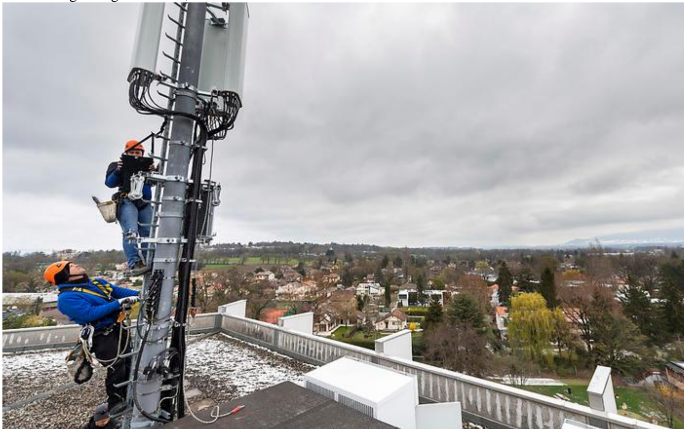
Montage einer 5G-Antenne in Chêne-Bougeries am 5. April im Kanton Genf. KEYSTONE/MARTIAL TREZZINI
